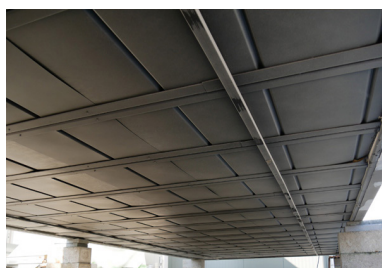
Anti-corrosie behandeling van kolom en bodemplaten.
